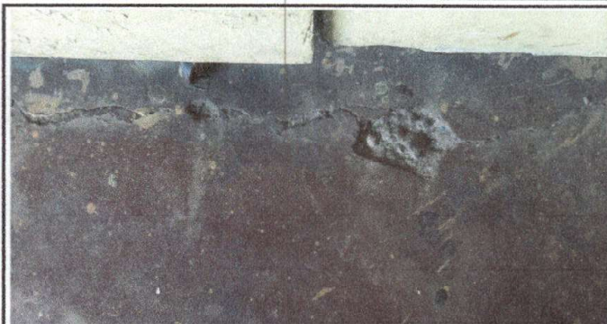
Foto 2: Sustitución de piso de cemento liquido Aula 2
