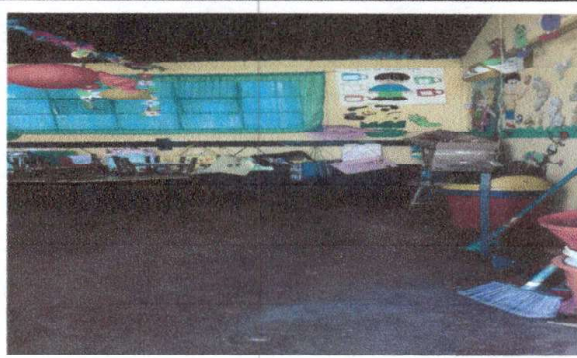
Foto 4: Sustitución de piso de cemento liquido Aula 4
